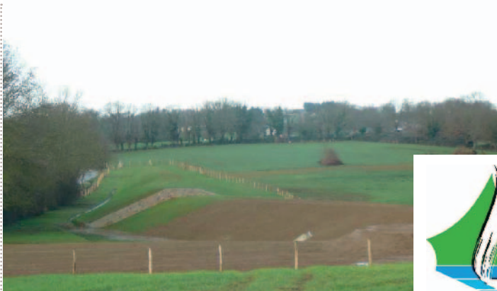
Ouvrage de Pelleterie
